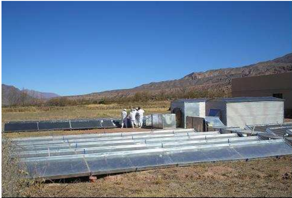
Figura 5: Vista nordeste del secador. Se observan los dos túneles de secado con sus respectivos bancos de colectores.
