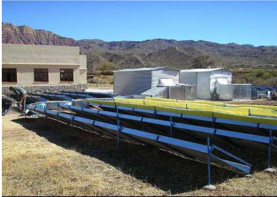
Figura 3: Vista posterior del banco de colectores en la etapa de construcción. Se observa también el túnel de secado, el cajón donde se coloca el ventilador y la conexión del caño maestro a este cajón.
