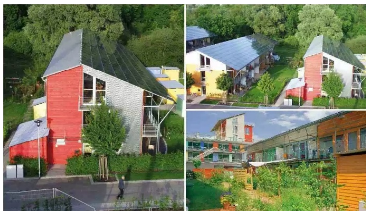
Figura 11: Viviendas con techo solar en Friburgo, Alemania.
