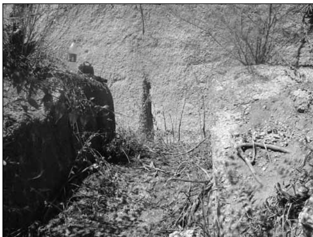
Figura 12. Rampa del Sector 5 en el complejo Piedra Raja. Nótese sobre la pared del cerro la marca confeccionada para encastrar una compuerta.
