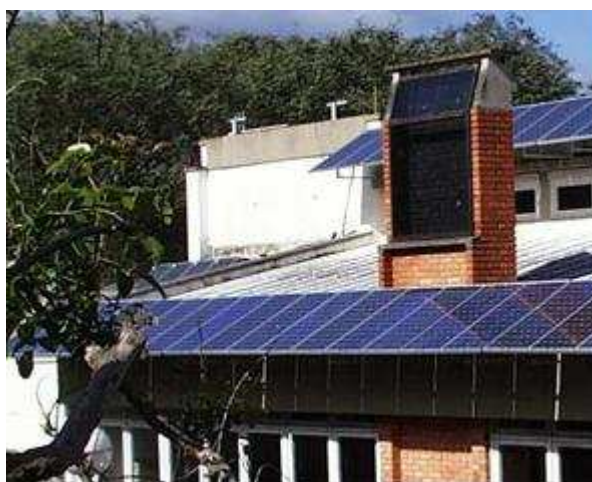
Figura 2: Prédio do Laboratório de Energia Solar da UFRGS
