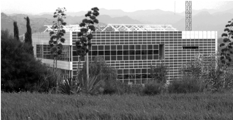
Figura 2: fachada suroeste durante la construcción. -Montaje de paneles cerámicos
