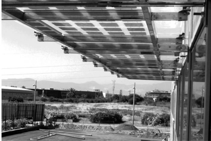
Figura 4: Parasoles fotovoltaicos, llamados "Damero". Desarrollo de diseño especial para esta construcción: Tedlar opalino, y equidistancia entre células y ristas.
