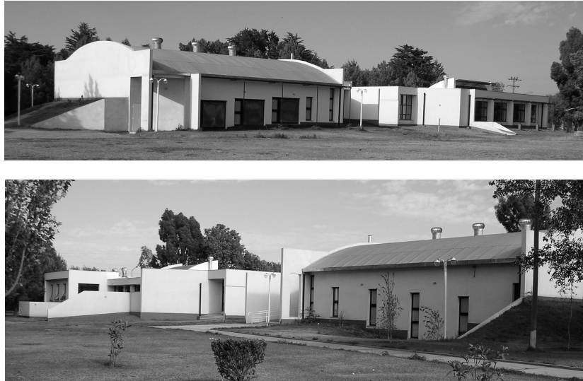
Figura 3: Vista norte (imagen superior: hacia la izquierda auditorio, hacia la derecha sala de lectura); Vista sur (imagen inferior: hacia la derecha auditorio; hacia la izquierda sala de informática)
