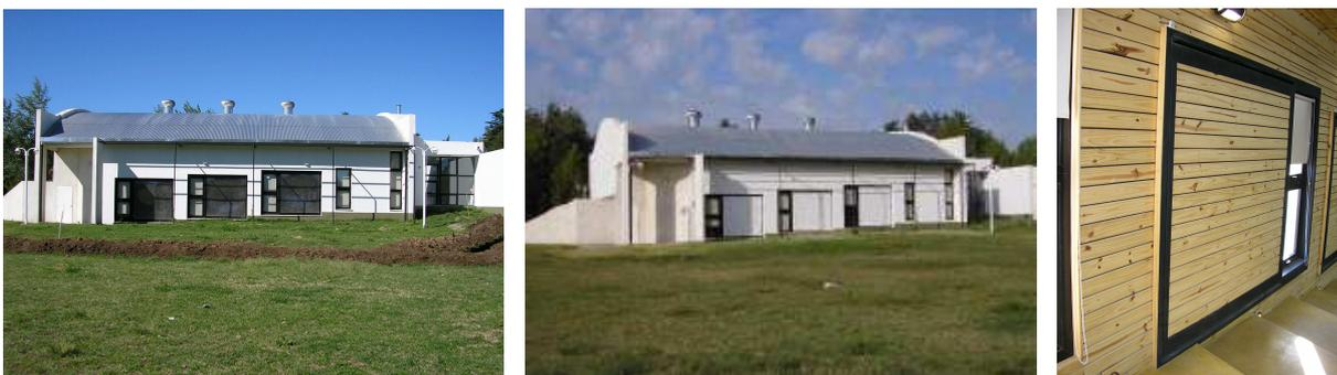
Figura 2: Vista exterior (con y sin toldos de sombreado) e interior de los colectores solares de aire en el muro Norte (por convección natural).
