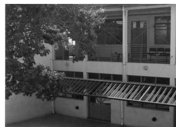
Fig. 2: Vista exterior galería con parasol
