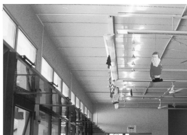
Fig. 3: Estantes de luz y cubierta de chapa reflejando radiación
