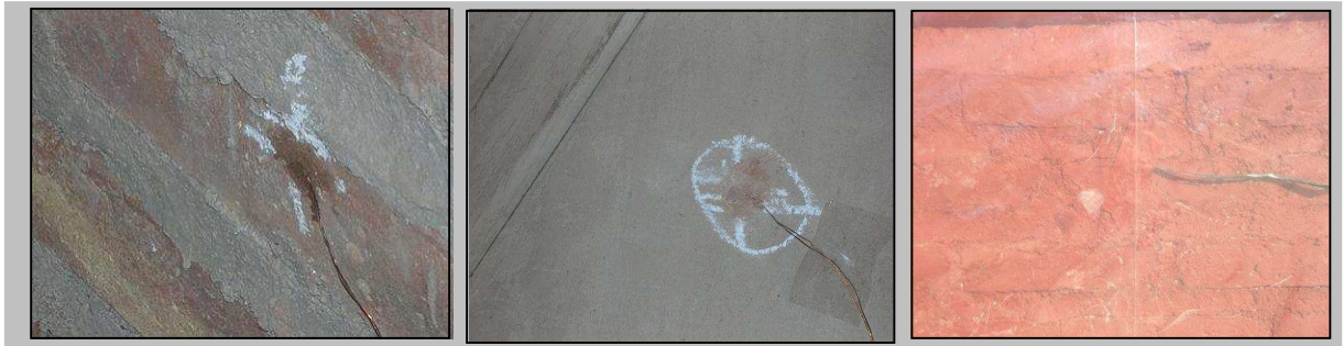
Figura 1: Termocuplas de los sensores HOBO, mimetizados con el muro. a: en basamento de ladrillo, b: en muro de quincha y c: en muro con color
