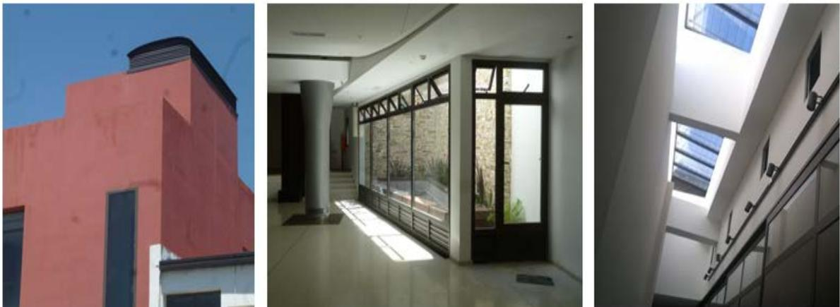
Figura 20. Imágenes de la chimenea escalera central, ventilación lateral patio inglés y lucarna lateral
