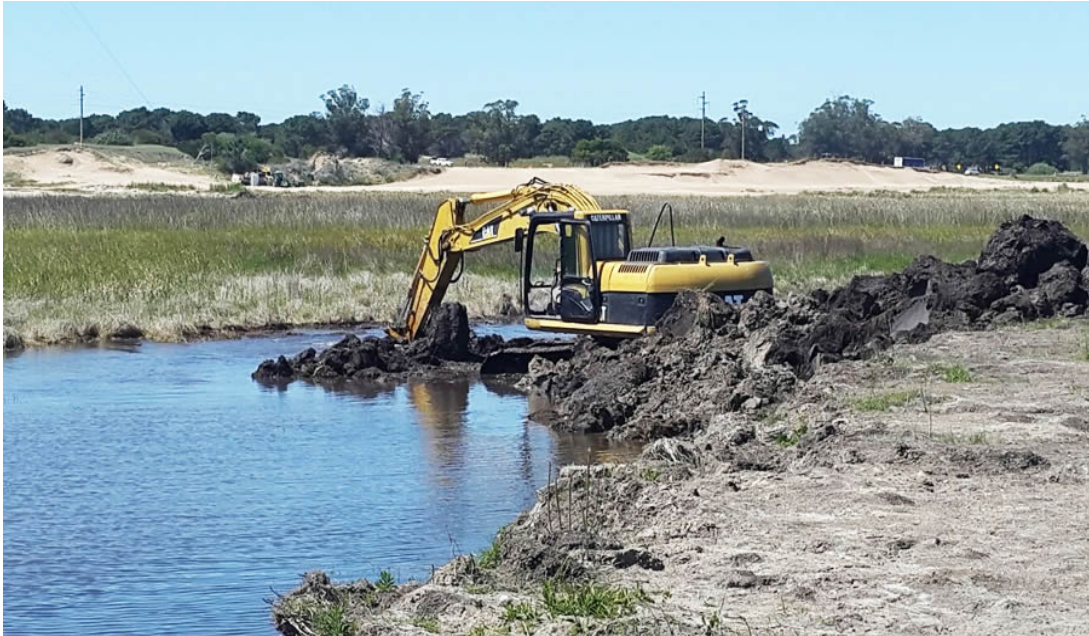
Figura 7. Obras en el mega emprendimiento “La Mansa” en Gral. Madariaga. Se organiza entorno a una laguna artificial. En este caso se observa la obra en proceso, la misma revaloriza las propiedades frentistas, al tiempo que extrae material para elevar cotas de altura del terreno. Fuente: http://www.lamansagreencity.com/obra.html
