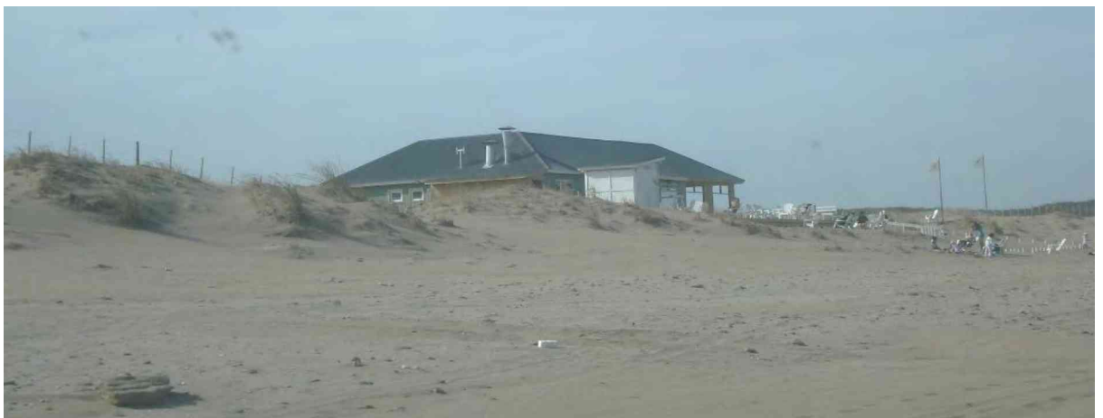
Foto 40. Costa. Grado de riesgo bajo. Costa Esmeralda. La Costa. 10/2008. Fuente propia
