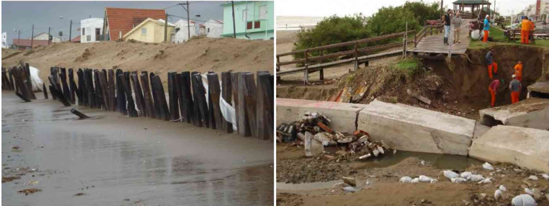
FOTOGRAFÍA N°1 y 2: EFECTOS DE UNA TORMENTA DE FEBRERO DE 2008 EN SANTA TERESITA, LA COSTA Fuente: Municipalidad de La Costa
