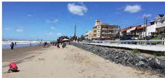
Foto 47. Colocación de gaviones. Santa Teresita – Mar del Tuyú. La Costa. 11/2018. Fuente propia
