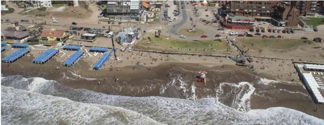
FOTOGRAFÍA N°19: PINAMAR. AV. COSTANERA Y BUNGE. SITUACIÓN PREVIA A LA IMPLEMENTACIÓN DEL PLAN Fuente: Municipalidad de Pinamar.
