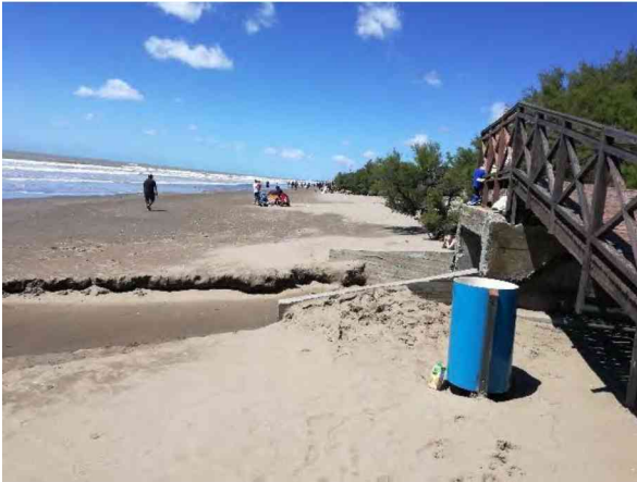
Foto 25. Costa. Grado de riesgo muy alto. Mar del Tuyú. La Costa. 11/2018. Fuente propia
