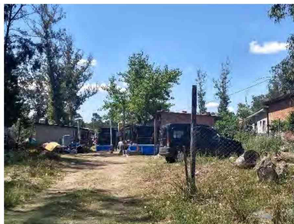
Foto 42. Zona urbanizada. Grado de riesgo alto. Ostende 12/2018. Fuente propia
