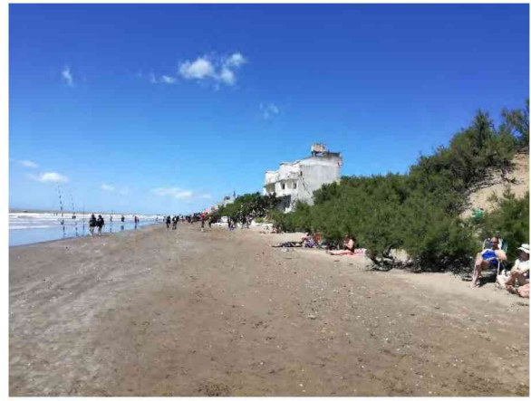
Foto 26. Costa. Grado de riesgo muy alto. Mar del Tuyú. La Costa. 11/2018. Fuente propia
