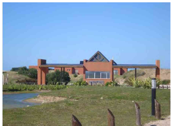
Foto 20. Zona urbanizada. Urbanización cerrada. Punta Médanos. La Costa. 11/2010. Fuente propia
