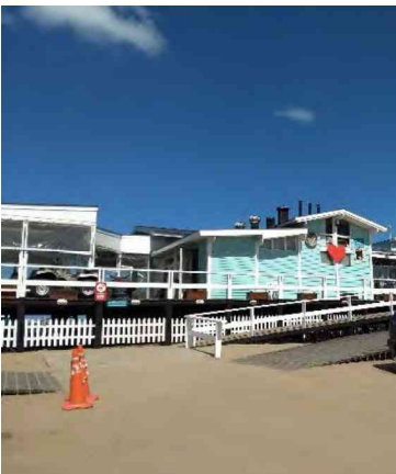
Foto 56. Renovación de balnearios con materiales desmontables. Villa Gesell 02/2019. Fuente propia
