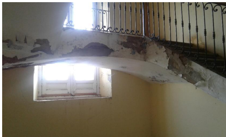
Escalera de ingreso
