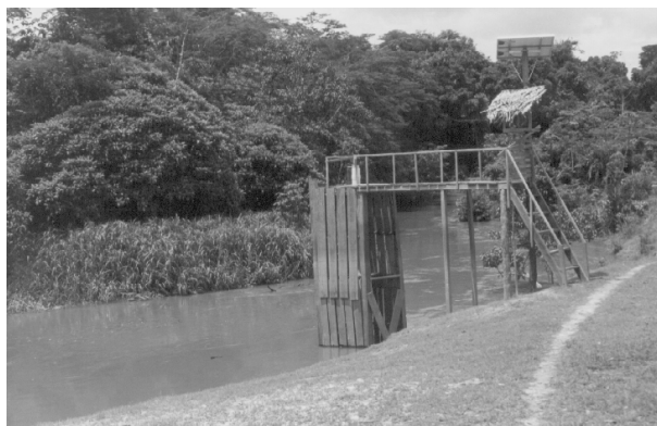
Figura 4. Sistema de bombeamento na várzea, em terreno com baixa permeabilidade, em época de estiagem.
