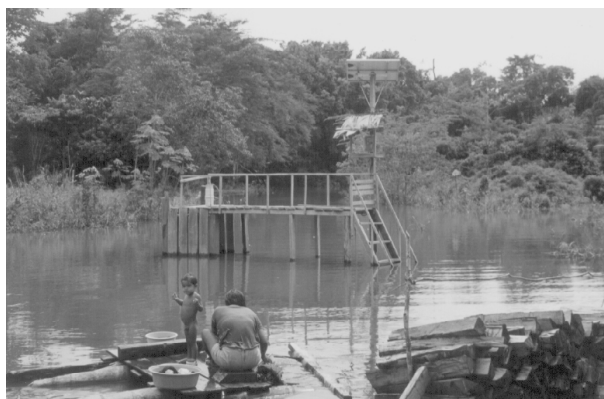
Figura 6. Sistema de bombeamento na várzea, em terreno com baixa permeabilidade, em época das chuvas.
