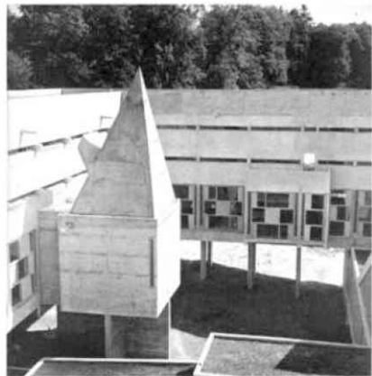
Figuras 7 y 8: Interior patio.
