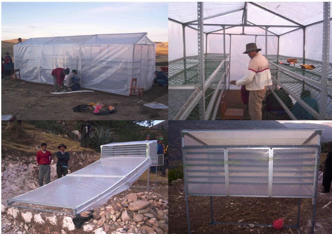
Figura 7: Las dos fotografías de arriba muestran el exterior e interior del secador solar de tiro libre modelo invernadero instalado en san francisco de Raymina; las fotografías interiores, muestran al secador solar indirecto de tiro forzado modelo híbrido vista anterior y posterior por donde se realizará la carga y descarga del producto; este secador ha sido instalado en San José de Tía.
