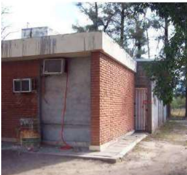
Fig. 5.- Vista externa de la cámara de cría
