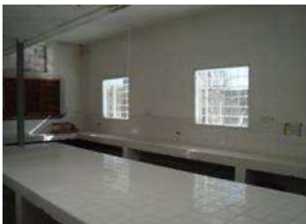
Fig. 19.- Foto del interior de la sala con iluminación desde ventanas norte.
