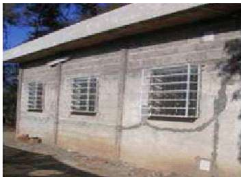
Fig. 14. Ubicación de estantes en las ventanas fachada norte
