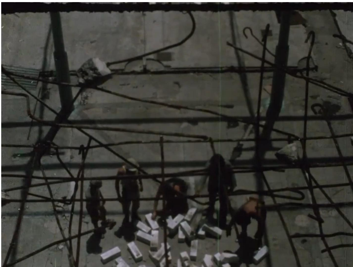
Figura 11. Los obreros comienzan a acarrear los ladrillos de la construcción.
