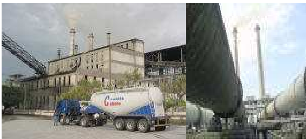
Figura 2. Instantáneas de la Fábrica de cemento Siguaney de Sancti Spiritus.
