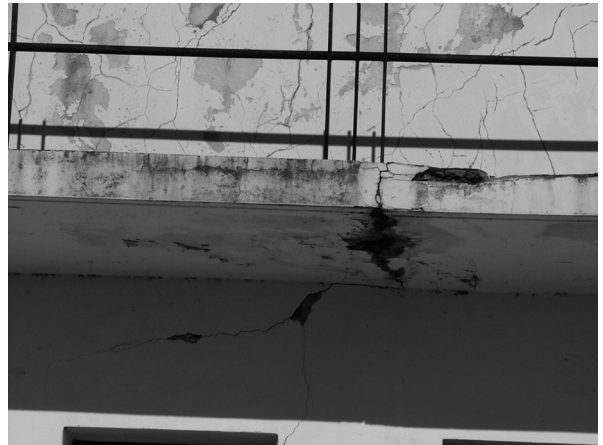
Imágenes 12 y 13: Fisuras en la ampliación del edificio principal.
