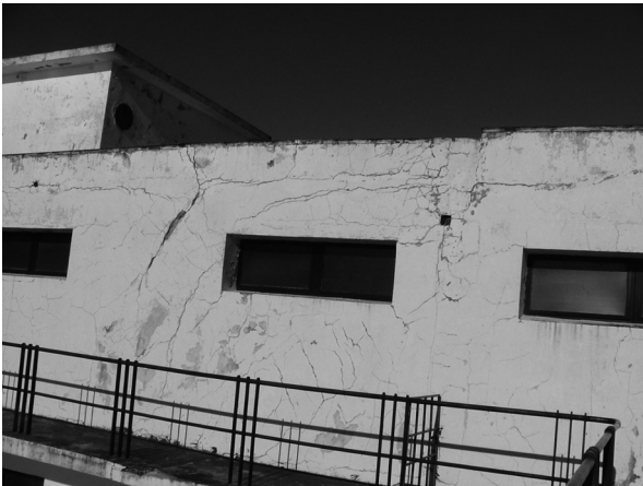
Imágenes 12 y 13: Fisuras en la ampliación del edificio principal.
