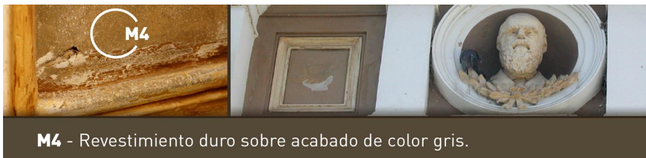
Figura 6 - Revestimiento sobre acabado
