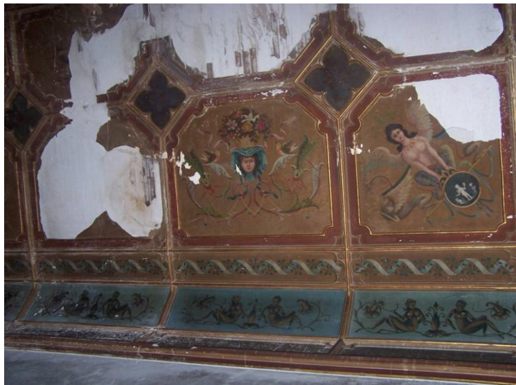
Figura 13 - Detalle muro interior
