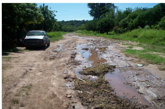
Foto 1: cárcavas en calle de Aguaray por erosión fluvial
