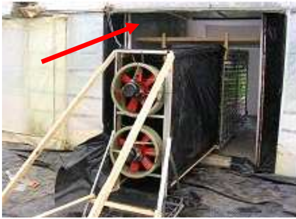
Figura 3. Vista del pleno de estabilización del aire y del ducto de retorno indicado por la flecha
