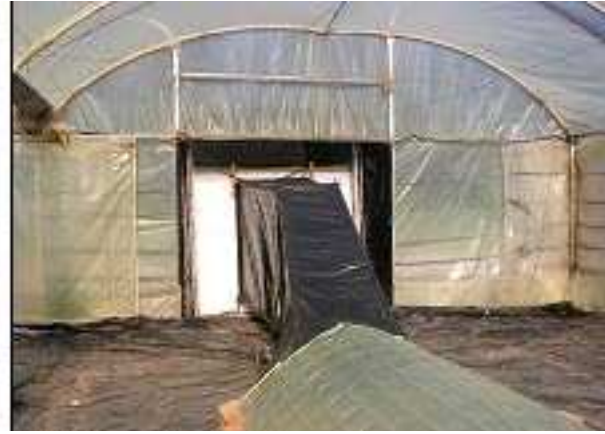
Figura 4. Vista del colector, pleno y cámara
