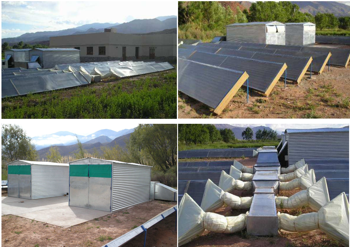
Figura 2: Secador Solar de Huacalera, Quebrada de Humahuaca. Vista de colectores, cámara de secado y caño maestro del secador.
