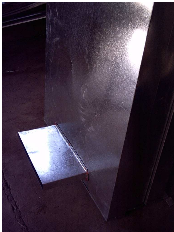
Figura 3: Conducto que comunica el colector con el edificio
