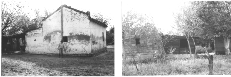
Figuras 4 y 5: Espacios y envolvente arquitectónica: Volumen principal y locales construidos posteriormente.
