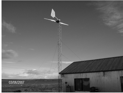
Figura 5 – El Cerrito /DPV con Aerogenerador INVAP (4.5kW nominales) – banco de baterías OpzS tubular 48V - 2007
