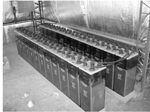
Figura 5 – El Cerrito /DPV con Aerogenerador INVAP (4.5kW nominales) – banco de baterías OpzS tubular 48V - 2007
