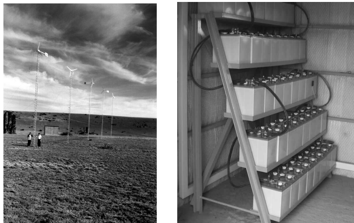
Figura 4 – Escuela Rural las Vegas – Aerogeneradores Eolux (2001) y reemplazo del banco de baterías (2004)
