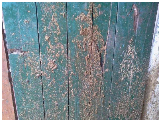
Foto N°1. Pared del box de alojamiento mostrando el producto de las diarreas explosivas.
