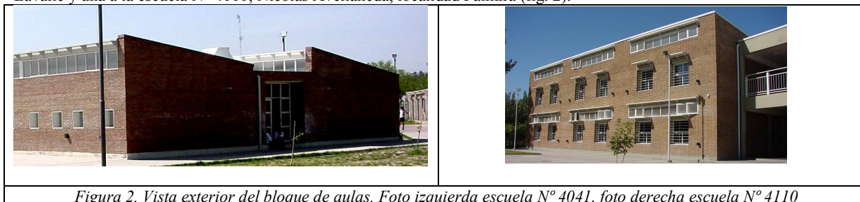
Figura 2. Vista exterior del bloque de aulas. Foto izquierda escuela N° 4041, foto derecha escuela N° 4110
