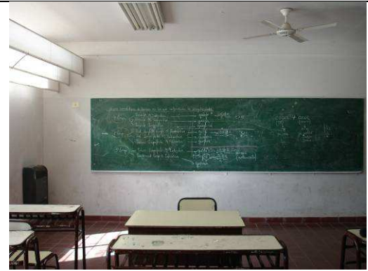
Fig. 7. Fotos interior del aula y detalle de difusores traslucidos (policarbonato alveolar)
