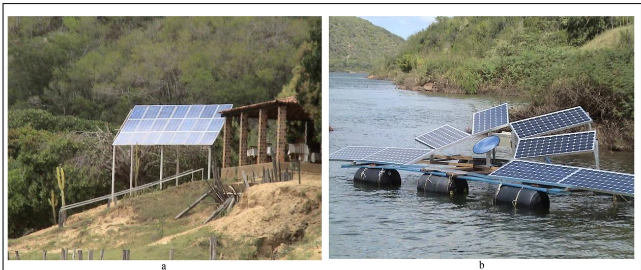
Figura 2-Sistemas fotovoltaicos atuais (2007): a) Geradores fotovoltaicos dos três sistemas: 440, 880 e 990 Wp; b) sistema de bombeamento: gerador 1,25 kWp, moto bomba de superfície e conversor de frequência.
