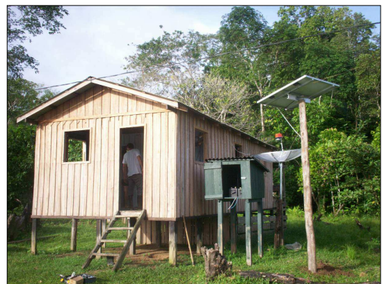
Figura 5. Vivienda de madera con techo de planchas acanaladas de amianto, junto al generador fotovoltaico y la caseta de baterías. [Foto: Federico Morante]
