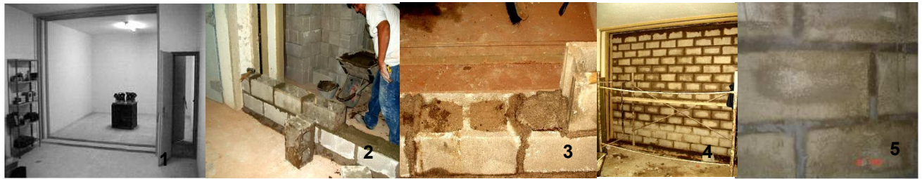
Figura 4: construcción del muro en el Laboratorio de Sonido UTN- Reg. Mendoza: cámara de sonido (1), pegado de los bloques (2), relleno con arena gruesa (3), cierre de la cámara (4) y bolseado de las juntas (5).
