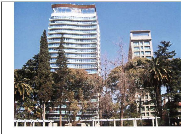
Figura 3: Edificio Da Vinci
