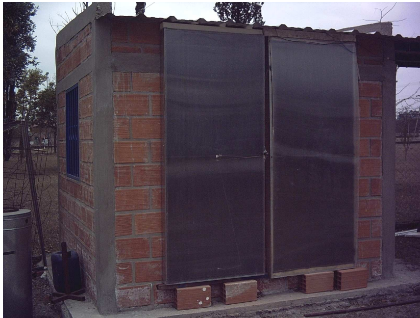
Figura 2: Vista del local con los dos colectores de loop convectivo vertical desarrollados. A la izquierda se ubica el de placa perforada ensayado en este trabajo.
