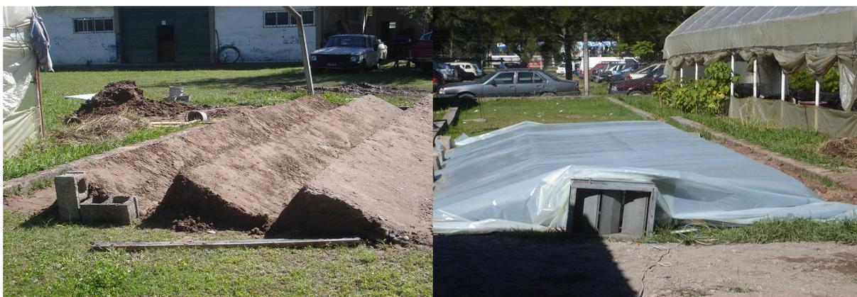
Figura 2 a: Etapa constructiva del colector de suelo cemento. Figura 2 b: Colector armado con ventilador axial.
