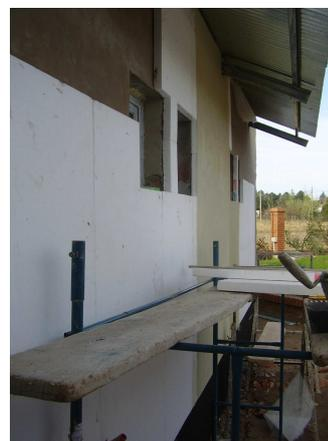
Figura 3 : Terminación sobre aislación térmica en el muro sur
