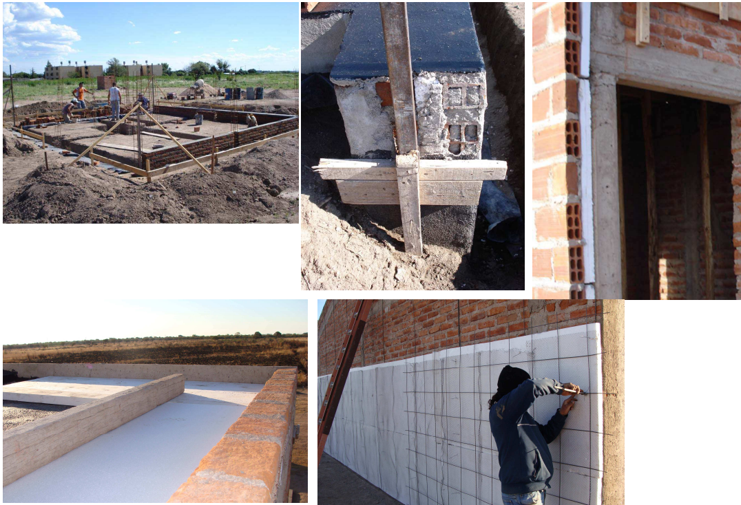
Figura 10 : Cimientos y su correspondiente aislación térmica
