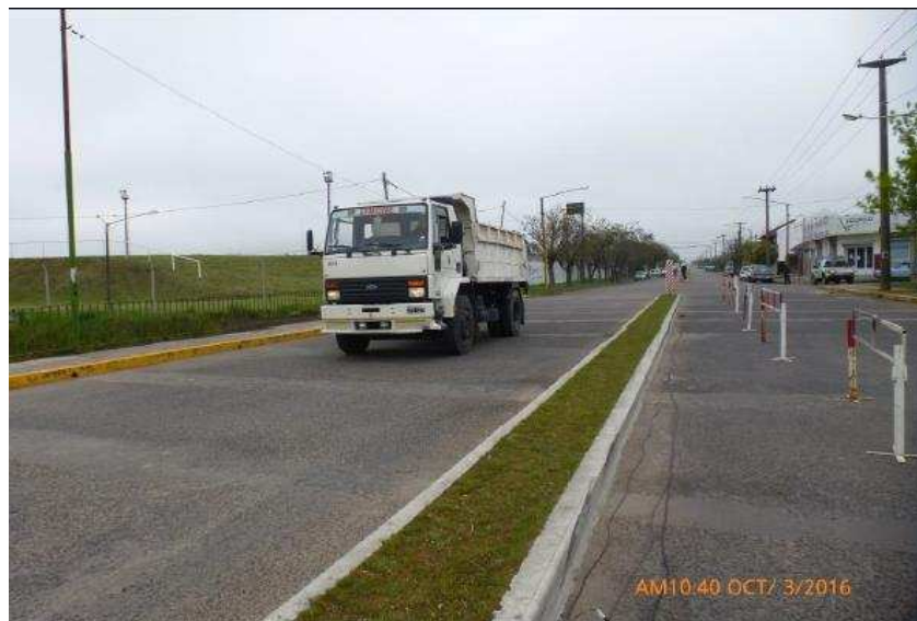
Figura 18: Tablero del puente con separador en instancia de medición en 2016
