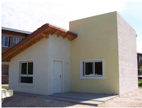
Figura 3: Foto Fachada Principal Este - Norte.
