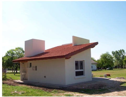
Figura 4: Foto Fachada Sur - Este.
