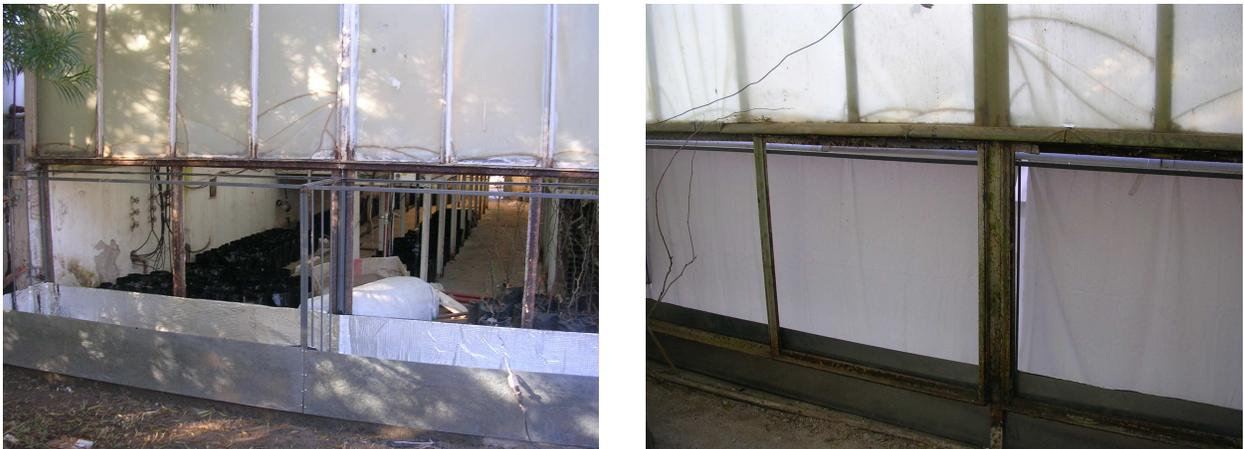
Figura 3: fotos del intercambiador antes y después de colocadas las telas
