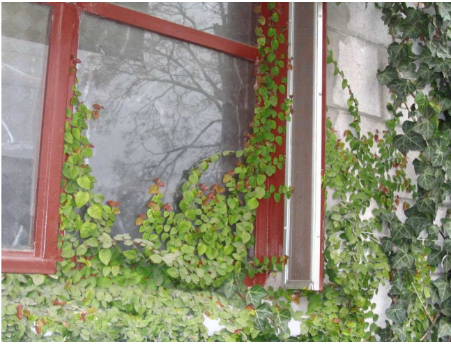
Fig. 7 – Detalle de uno de los conductos en su toma exterior con malla metálica como mosquitero.
