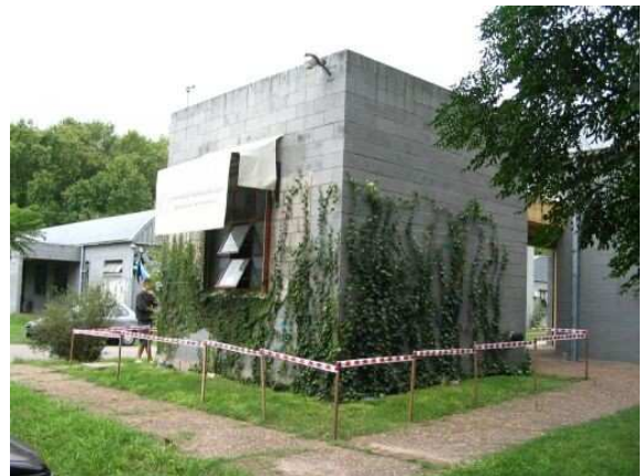
Fig.1 – Vista actual del recinto utilizado como Laboratorio
