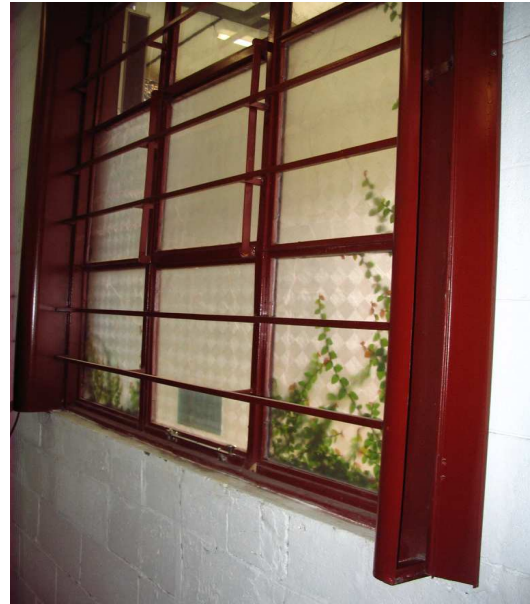
Fig. 8 – Vista de la salida interior del conducto y su tapa
