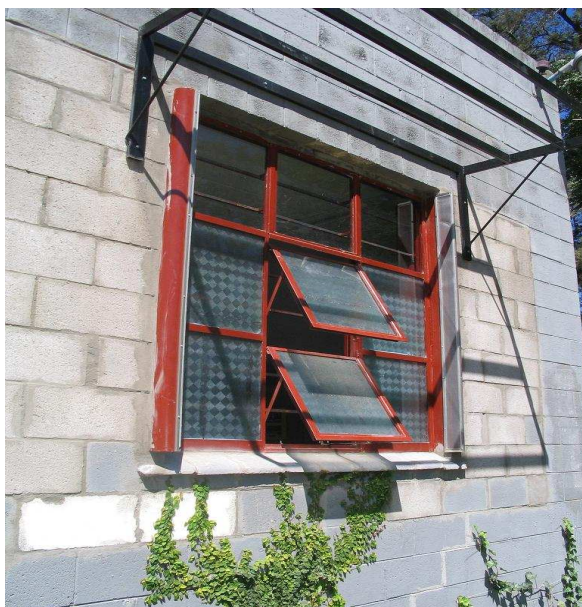
Fig. 6 – Vista exterior de la ventana colocada
