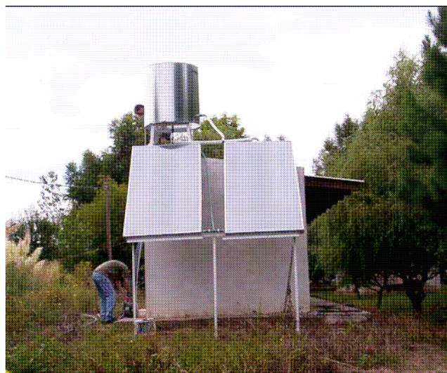
*Figura 3. Colectores planos para el calentamiento de agua y tanque de acumulación en el Camping “El Cielo”.*
