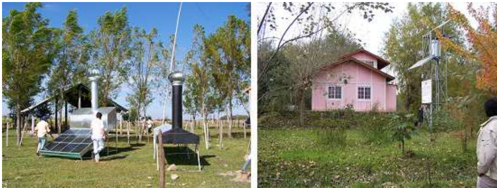
Figura 1. Equipos instalados en diferentes localizaciones
