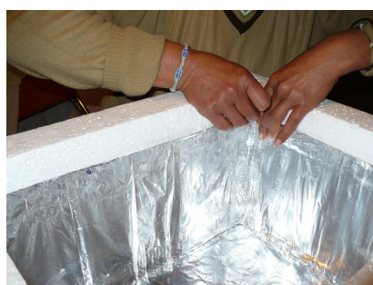
Figura 6. Forrado interno y de bordes con cartón y papel aluminio
