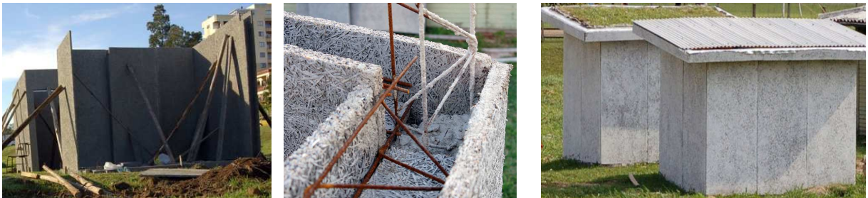
Figura 2: a-Montaje de las placas PCM; b-Detalle de la armadura de pilar y viga de la cubierta; c-Finalización de los prototipos.
