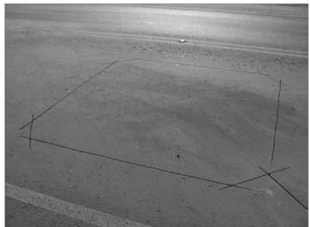
Foto 5. Se asera un cuadrado de 2 m por 2 m en el pavimento para instalar la espira.
