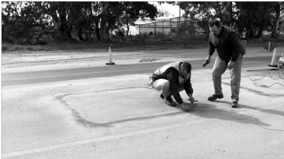
Foto 7. Luego del corte en el pavimento se introduce el cable para formar la espira.
