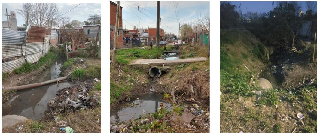
**Figura 72.** Imágenes de conexiones informales al desagüe.
