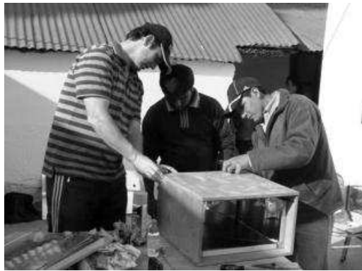
Figura 2: Tareas de construcción de cocinas solares con gente de la comunidad
