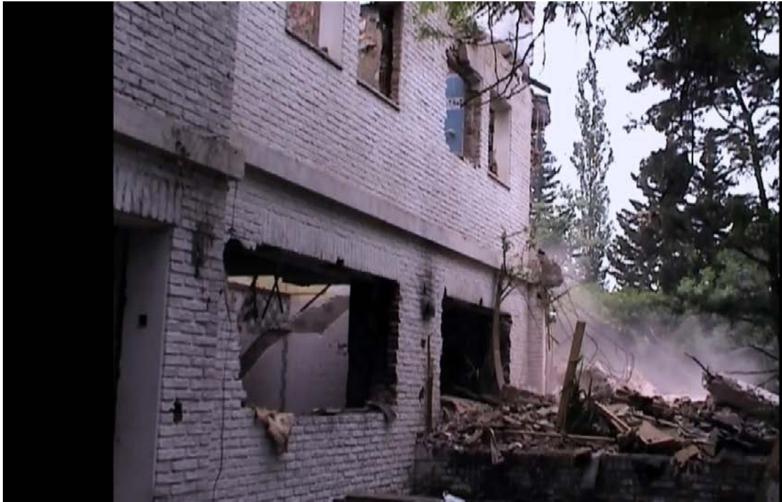
Figura 3. La demolición de la casa en La sombra (Olivera, 2015)
