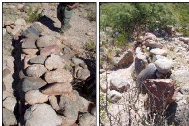
Figura 4: Detalle de uno de los muros dobles sin relleno de los recintos rectangulares. 4b: Detalle de muro simple.
